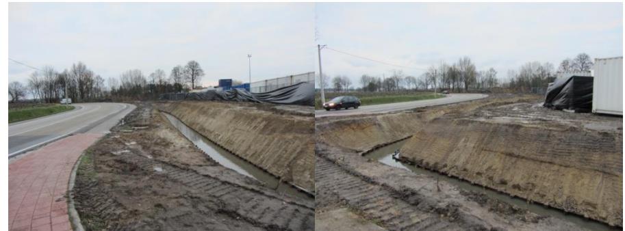
Figuur 22: Beersebaan en verlegde Kleine Mark in Z-richting (links) en aan zijde Driehoek (rechts)
