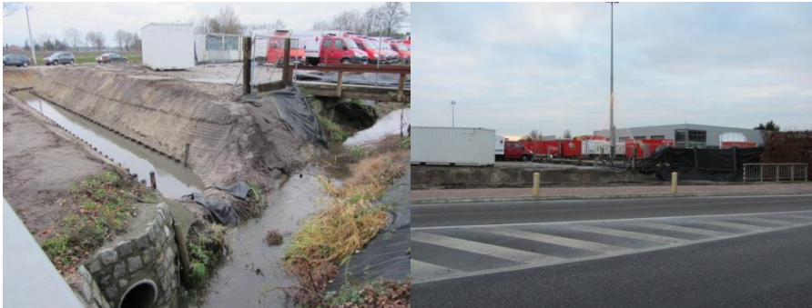
Figuur 23: zicht op de Kleine Mark en de verlegde loop van de Kleine Mark vanaf Driehoek (links), zicht op het bedrijf vanaf Driehoek in de richting van Rijkevorsel (rechts)
