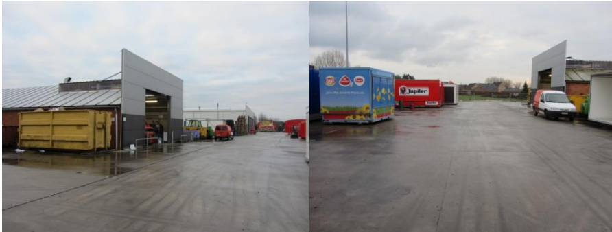
Figuur 15: zicht op het kleinste bedrijfsgebouw in N- richting (links) en in Z- richting (rechts)
