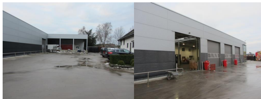
Figuur 14: zicht op de laad- en loskaai van het bedrijf, gelegen tussen het grootste bedrijfsgebouw en de bedrijfswoning (links); zicht op de zijgevel van het grootste bedrijfsgebouw (rechts)
