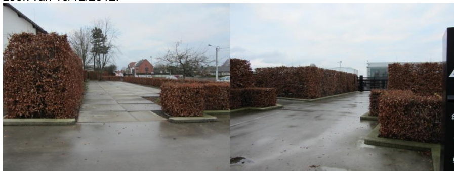
Figuur 12: zicht op de parking voor de bedrijfswoning (links); zicht op de linkse toegang vanaf Drijhoek (rechts)
